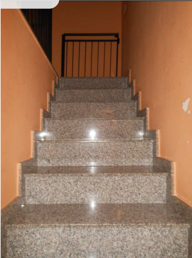
FOTO N.18 – VANO SCALA PIANO SECONDO
