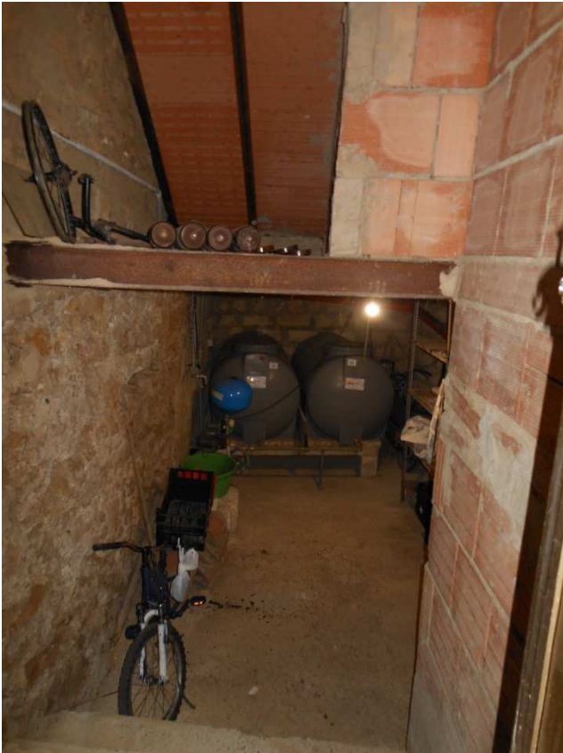
FOTO N.6 – PIANO SEMINTERRATO LOCALE TECNICO
