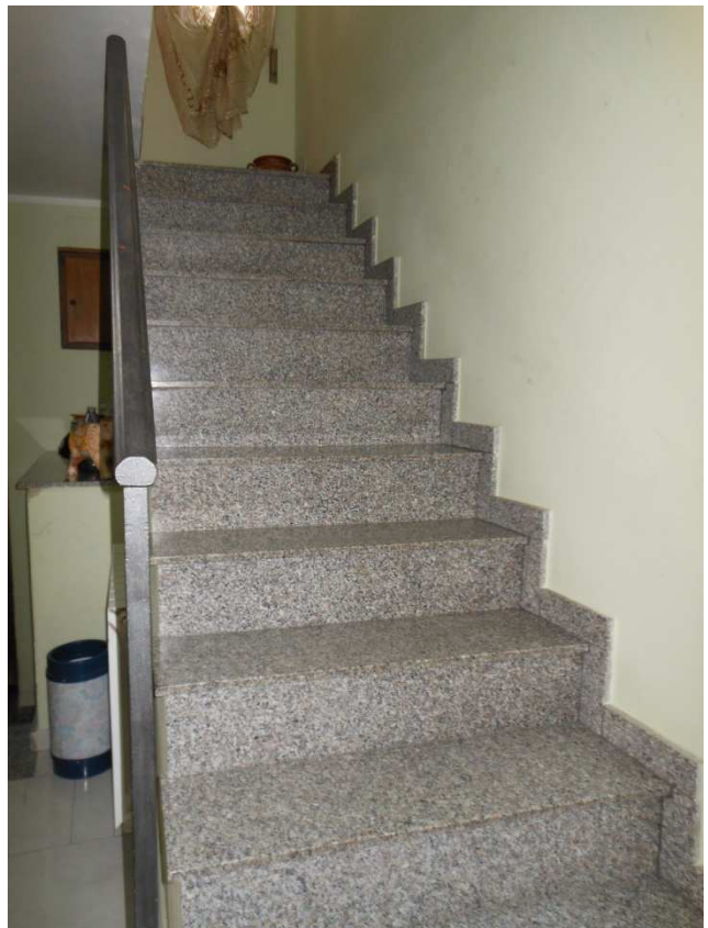
FOTO N.9 – PIANO TERRA VANO SCALA
