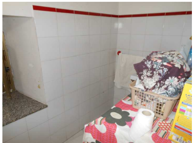
FOTO N.21 – VANO LAVANDERIA PIANO SECONDO
