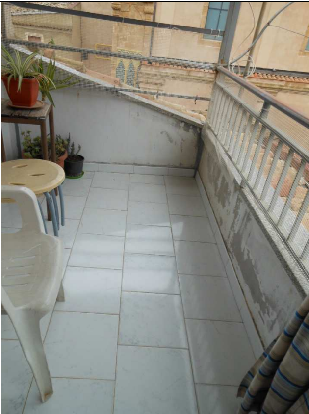
FOTO N.20 – TERRAZZA PIANO SECONDO
